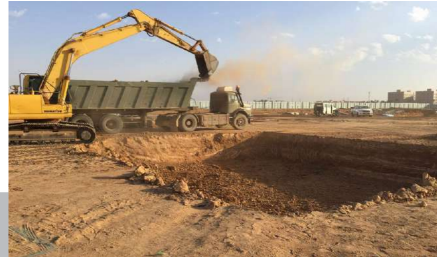
أعمال الحفر لمشروع المدارس بالمجمعة
