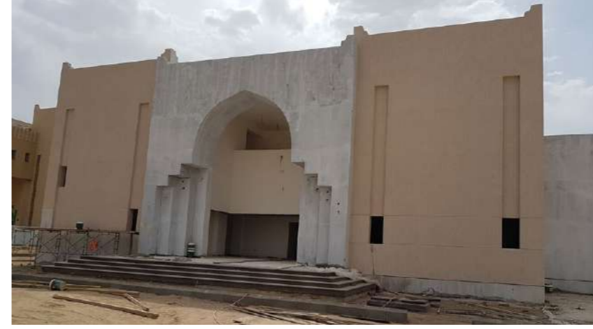
مشروع مبنى التقنية الميكانيكية نجران
