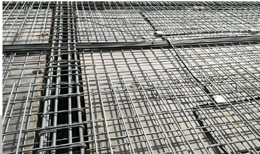
حدادة كمرات وبلاطة سقف الدور الثاني بالمبنى - عفيف
