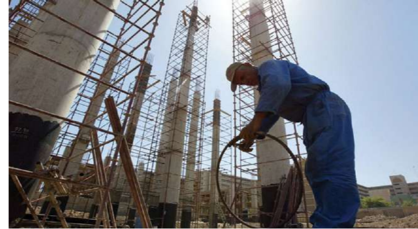
أعمال خرسانية للأعمدة مستمرة على ارتفاع ١٢ م لمشروع انشاء كلية العلوم بعنبر
