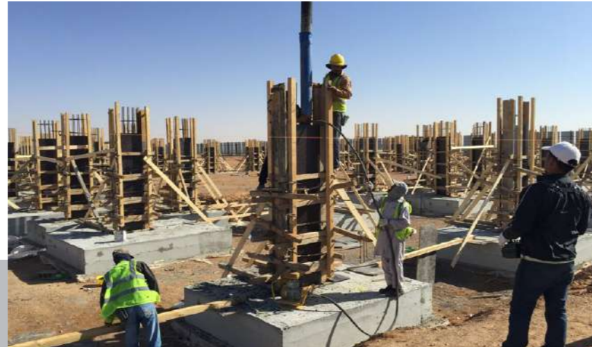
صب القواعد المسلحة لمشروع مدارس المجمعة
