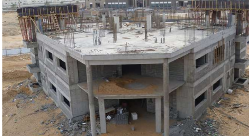
مشروع بالقصيم ( مبنى الإداري )
