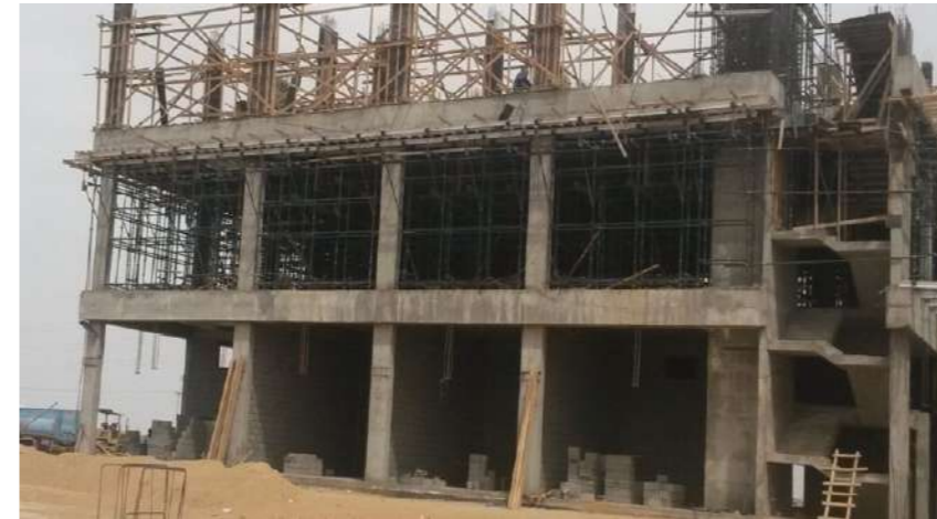
صب سقف الدور الأول المبنى الرئيسي - عفيف
