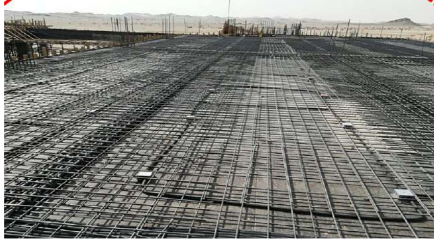
حدادة كمرات وبلاطة سقف الدور الثاني بالمبنى - عفيف
