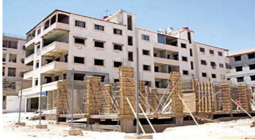
مشروع بناء مجمع سكني بجدة
