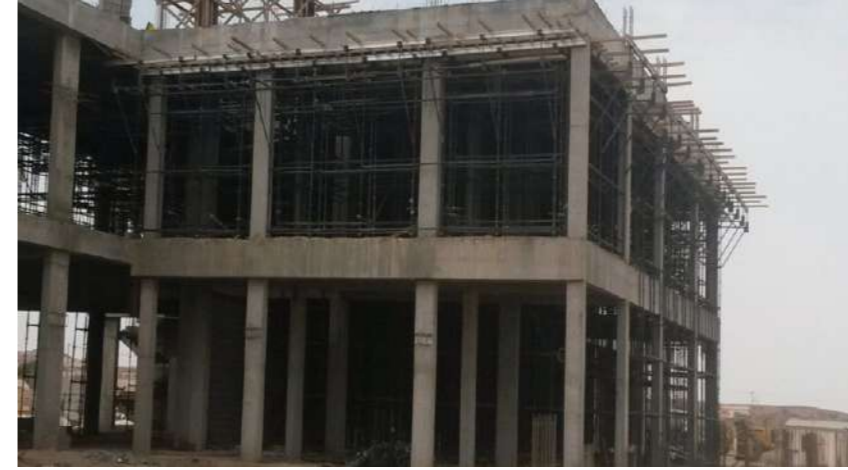
صب سقف الدور الأول المبنى الرئيسي - عفيف
