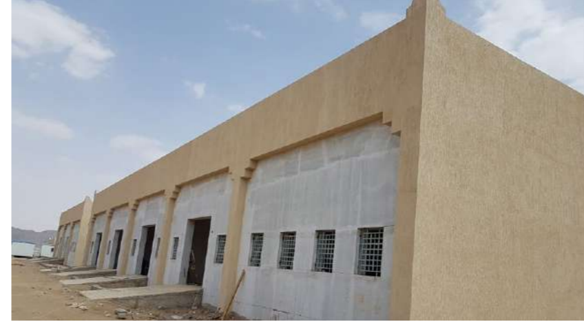
مشروع مبنى التقنية الميكانيكية نجران
