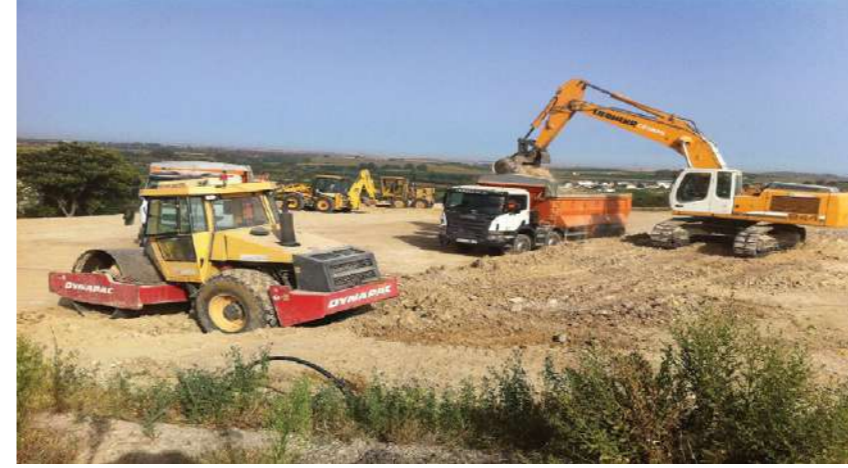
أعمال حفر لأحد المشاريع بالرياض
