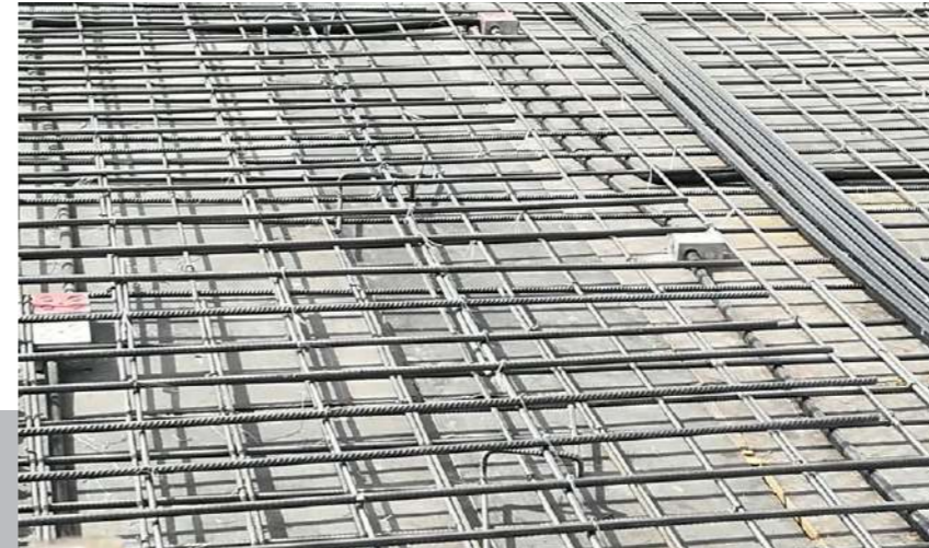
أعمال التمديدات الكهربائية بسقف الدور الثاني بالمبنى - عفيف
