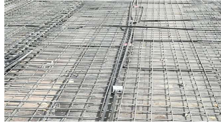
أعمال التمديدات الكهربائية بسقف الدور الثاني بالمبنى - عفيف
