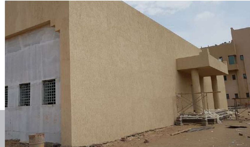
مشروع مبنى التقنية الميكانيكية نجران
